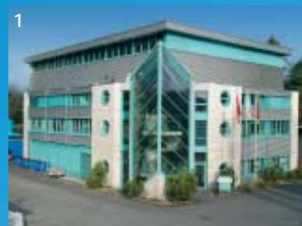
3 Bref aperçu de l'installation
